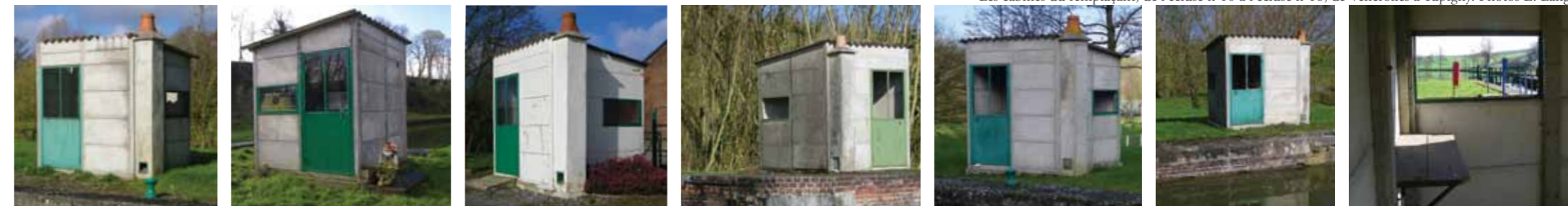
Les cabines du remplaçant, de l'écluse n°10 à l'écluse n°16, de Vénérolles à Tupigny. Photos E. Langer
